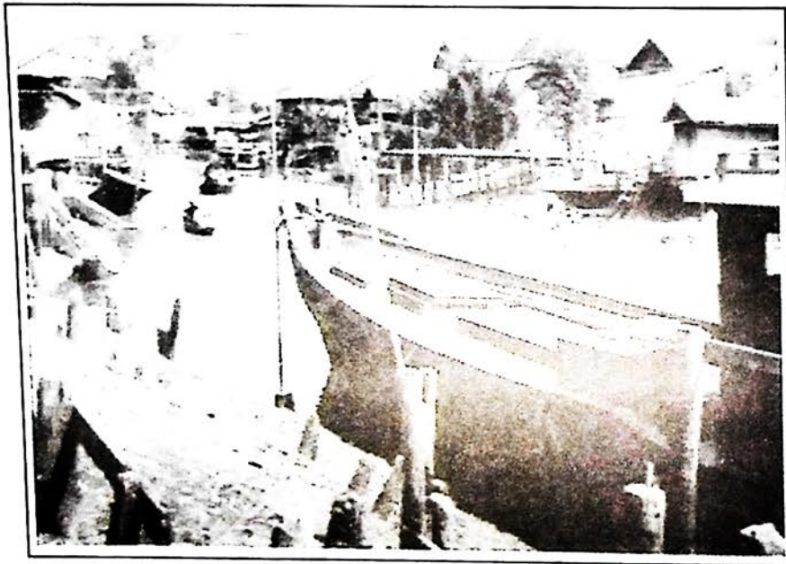
รูป ๑๔ ชุมชนคลองปากน้ำ บางเจ้าพระยา
