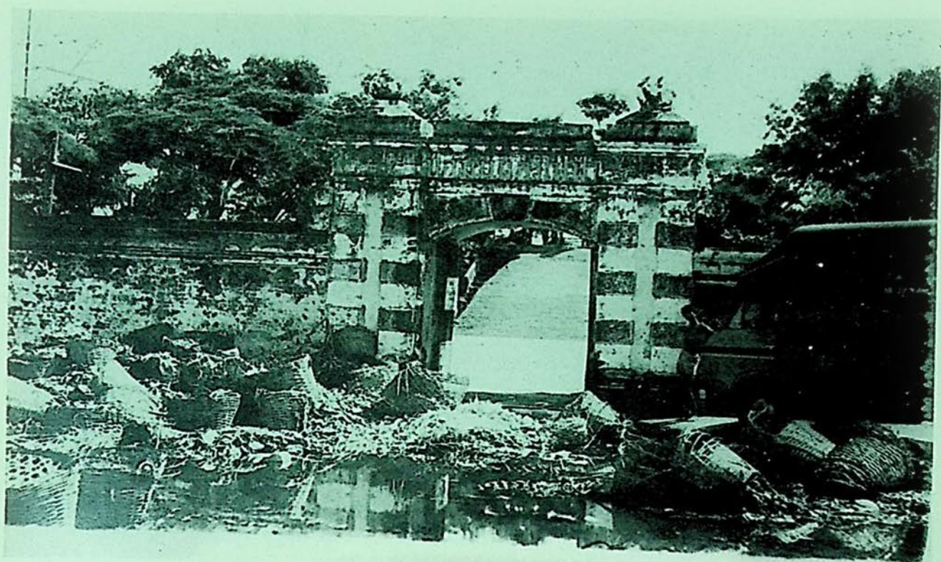
ประตูทางเข้าป้อมผลิตไฟฟ้า
