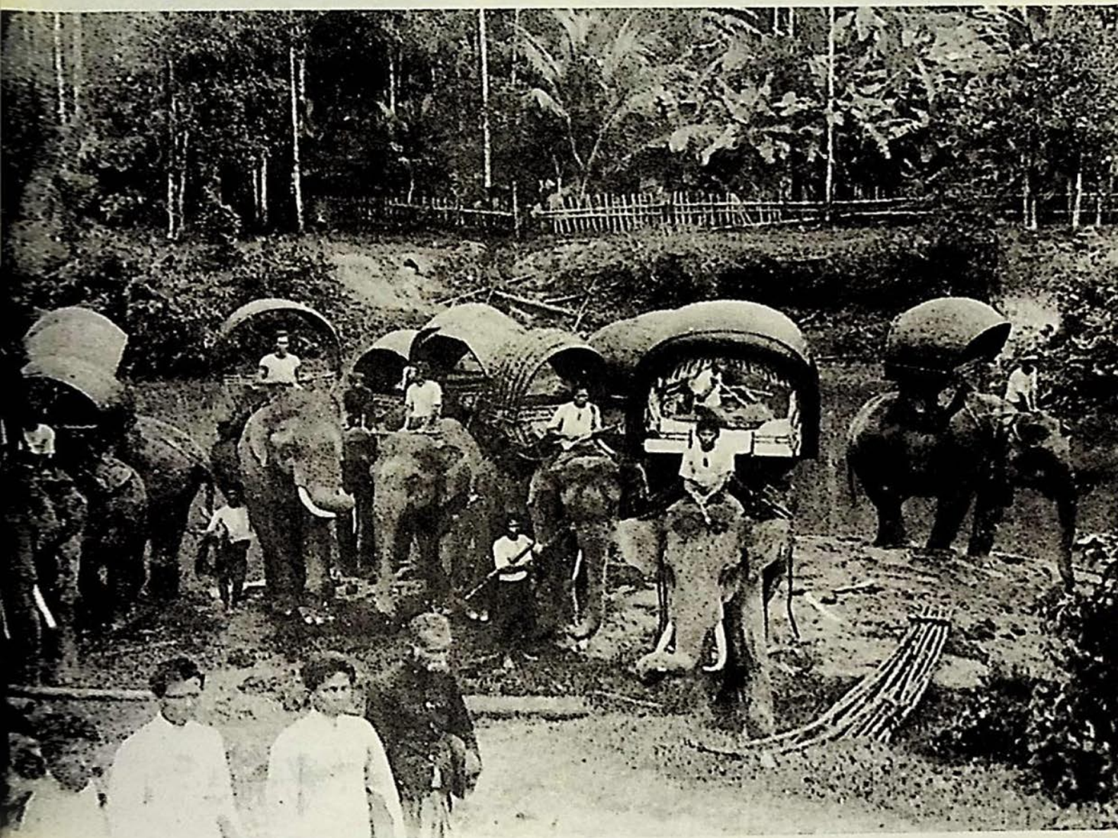
สมเด็จพระยาดำรงราชานุภาพ เสด็จตรวจการทำงานสร้างทางรถไฟสายใต้
