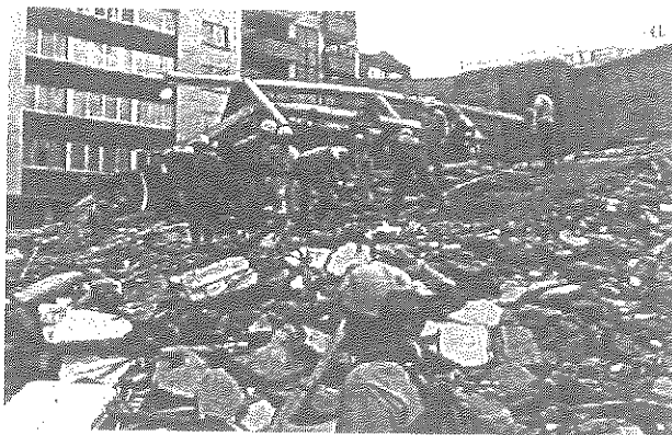
รูปที่ 6 การค้นหาทางกายภาพบนการถล่มแบบแผนแค้ก
